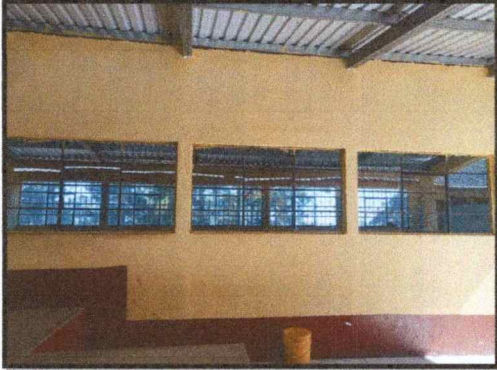
Foto1: VENTANAS: Para mayor protección se colocará balcon.
