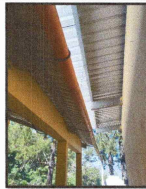
Foto 4: Se sustituiran los tubos pvc por canales de metal. Es prioridad para un mejor abastecimiento de agua, para uso de los alumnos.
