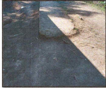
Foto 14: Urgente construcción de rampa de acceso.
