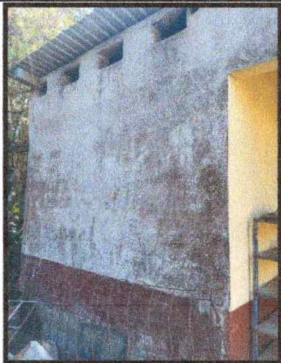
Foto 17: REPARACION O SUSTITUCION DE AREA COCINA
