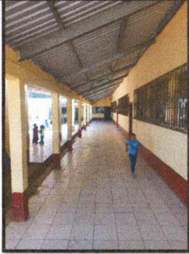
Foto7: PINTURAS EN MUROS
