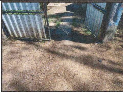
Foto 5: CUNETAS DE CONCRETO:
